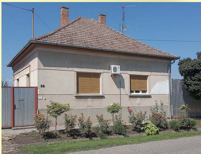
4. kép. Délelőtt erős napot kapó ingatlan virágágyással fasor nélkül. - Tápe, Rév u. - nyugati oldal (fotó: Korom A.)
