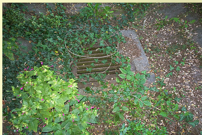
10. kép. Szentes, Mátéffy utca déli oldala, a mintaszerűen kialakított mélyületbe épített víznyelő részletfotója (fotó: Korom P.)
