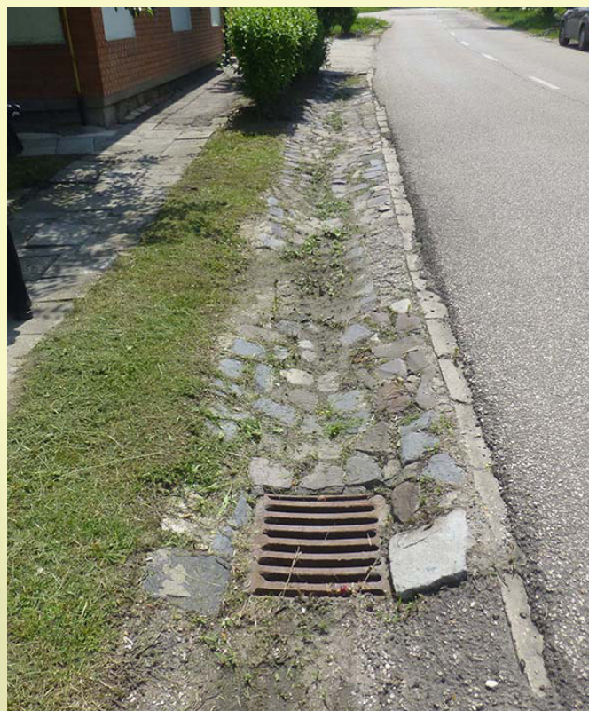
12. kép: Tápé, Veres P. utca, kőkirakású folyóka, alatta zárt csapadék csatorna (mintaszerű megoldás) (fotó: Korom A.)
